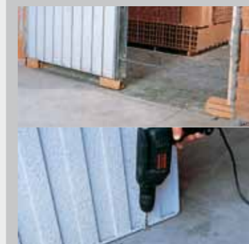
5a. Fijación sobre pavimento por terminar.
